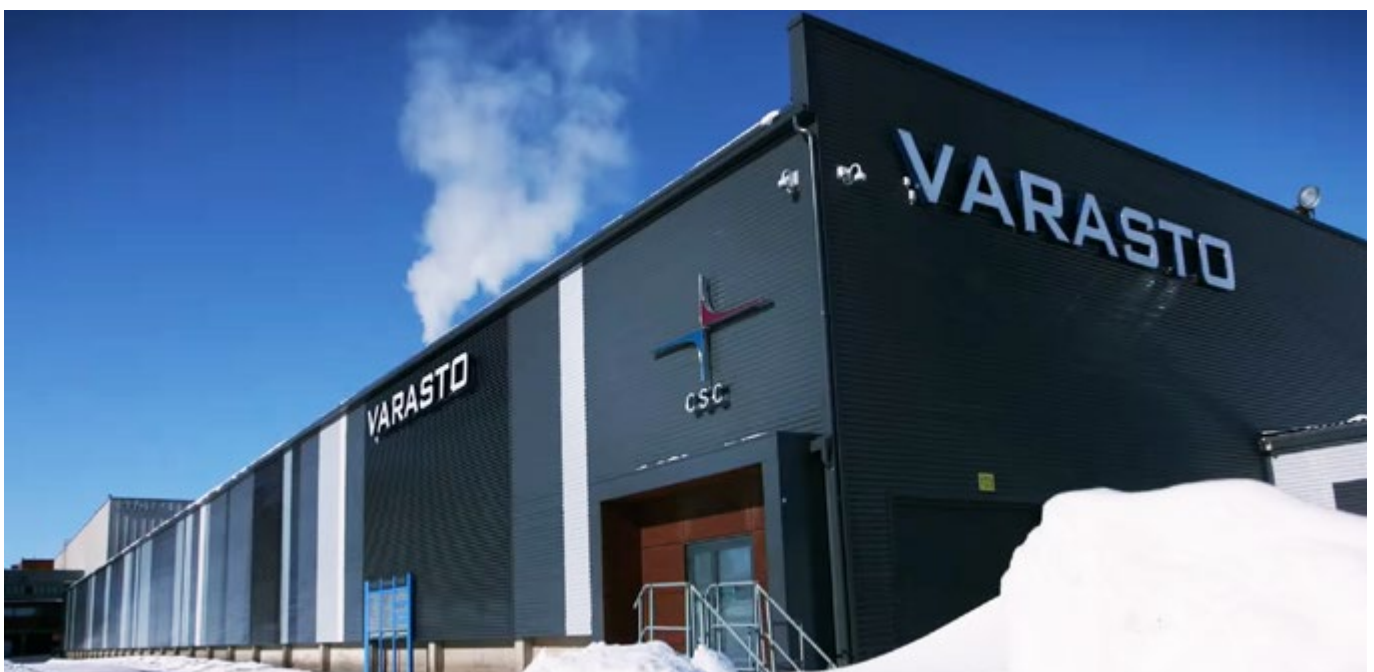
Kuva 9.1. CSC:n datakeskus Kajaanissa edustaa maailman kärkeä energia- ja kustannustehokkuudessa. Datakeskuksen käyttämä sähkö on 100% vesivoimalla tuotettua ja jäähdytykseen tarvittavan energian määrä erittäin pieni Kajaanin viileän ilmaston vuoksi.
