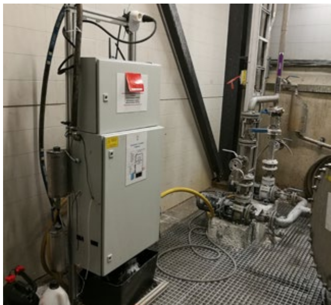
Kuva 4.2. BIOMIT-hankkeessa kehitetty reaaliaikainen NIR-mittalaite teollisuuden pilottikohteessa.
